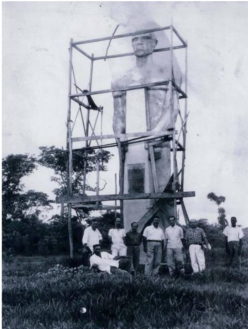
Construção do monumento conhecido como Bernardão
