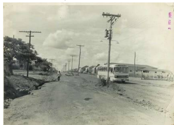
Arruamento na fase de construção de Fronteira
